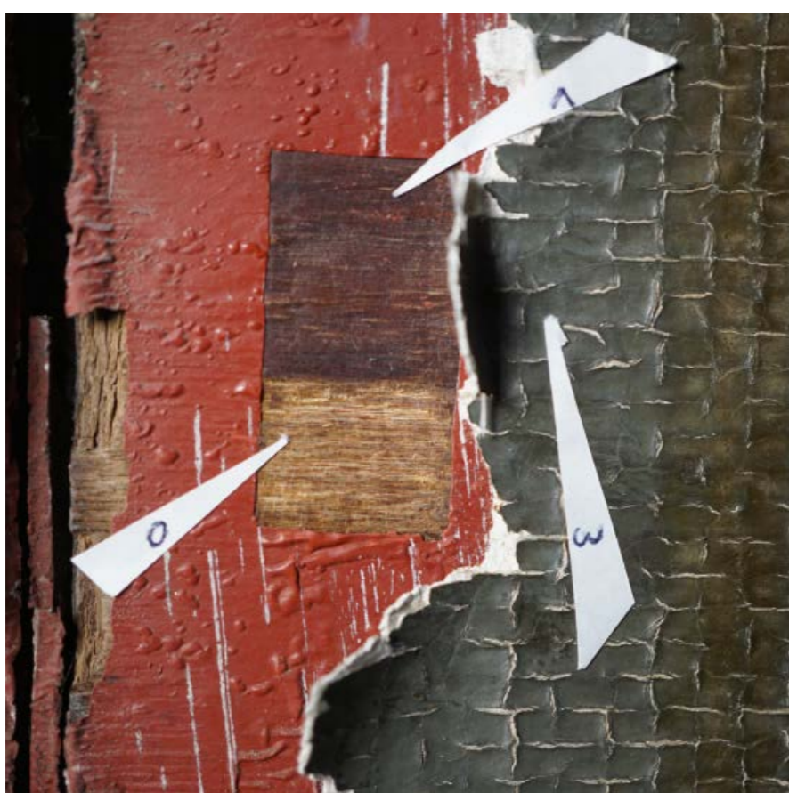
▲ Freilegungstreppe mit brauner primärer Überzugsgestaltung und starker Differenz beider Lackierungen
