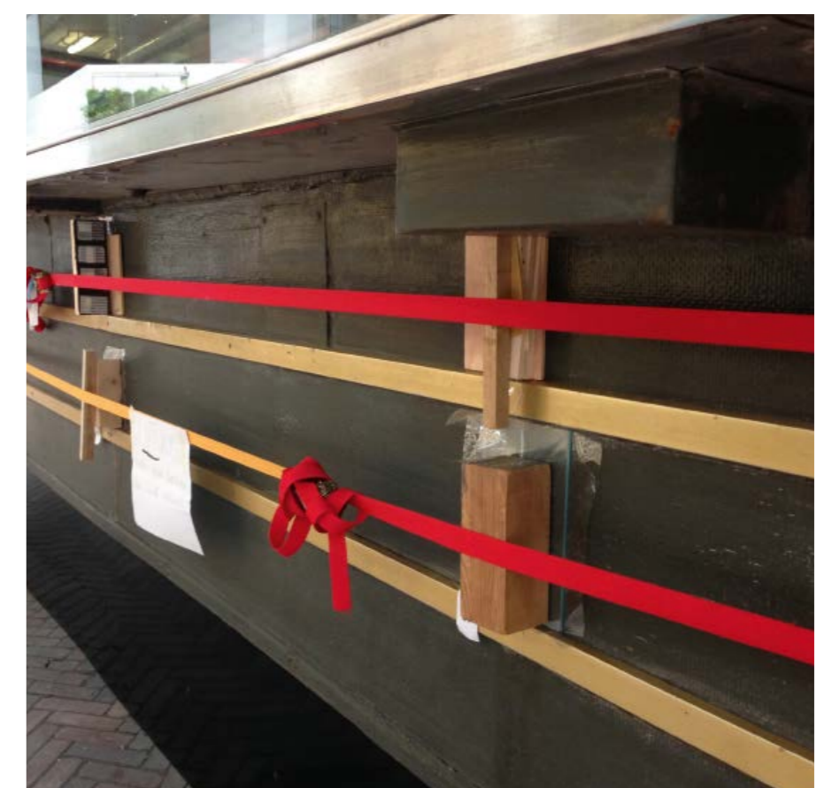
▲ Druckaufbau zum Verkleben der gelösten Materialien mit umlaufenden Spanngurten
